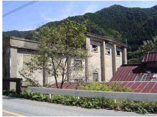
10. 新梨子油力発電所
